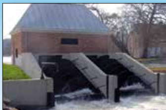
Wasserkraftanlage Heudreville (F)
